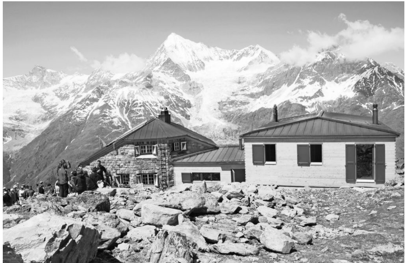
Herausgeputzt. Blick auf die frisch renovierte Domhütte.
